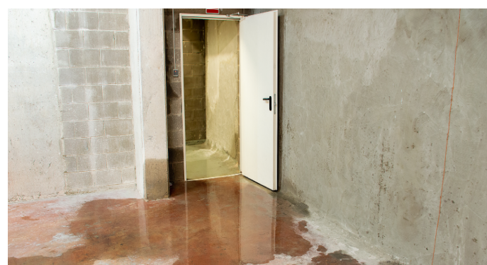
Feuchtigkeitsschaden im Keller lässt sich vermeiden – etwa indem man die Abdichtungen überprüft und gegebenenfalls austauscht oder nachrüstet.
