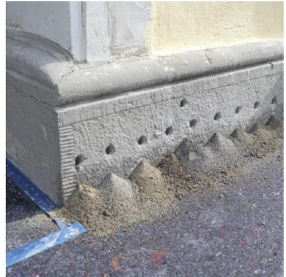
Ins stark durchfeuchtete Mauerwerk wurden Bohrlöcher für die Einführung von Heizstäben zwecks Austrocknung gebohrt.
