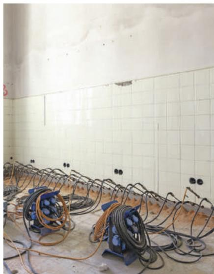
Bei der Horizontalsperre wird Spezialparaffin ohne chemisch-flüchtige Bestandteile eingesetzt.
