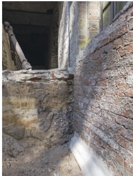
Für die Außenabdichtung waren Spezialputz und Bitumendickbeschichtung erforderlich.
