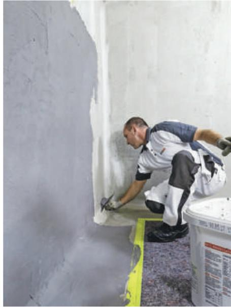
Auf einen wassersperrenden Putz als Dichtputz wird mit der Kratzspachtelung die Kombiflex aufgetragen – nahtlos auch im Wand-Sohlen-Anschluss.
