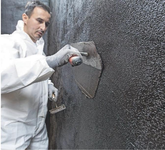
Auftrag der kunststoffmodifizierten Bitumendickbeschichtung KMB, hier mit Isotec-VAS.
