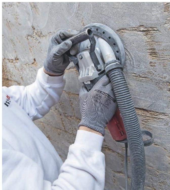
Das gereinigte Mauerwerk wird für optimale Haftvermittlung abgeschliffen. Der Schlauch des Schleifgerätes sorgt dafür, dass der Innenraum möglichst wenig mit Staub belastet wird.
