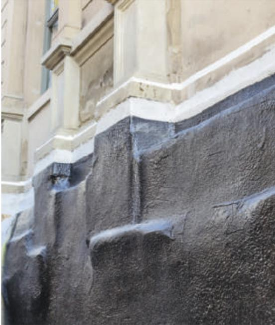
**Schritt 1: Außenabdichtung mit Spezialputz und Bitumendickbeschichtung.**
