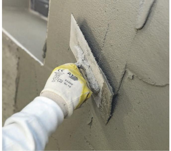
Auftrag der rissüberbrückenden, mineralischen Dichtungsschlämme, hier die Kombiflexabdichtung.
