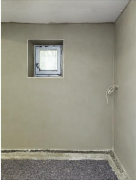
Nach erfolgter Sanierung ist die Innenwand gegen Feuchtigkeit abgedichtet; der Kellerraum kann ganz neu genutzt werden.
