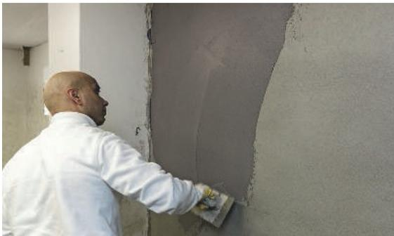
Auftrag der Kombiflexabdichtung auf Dichtputz respektive Wassersperrputz.
