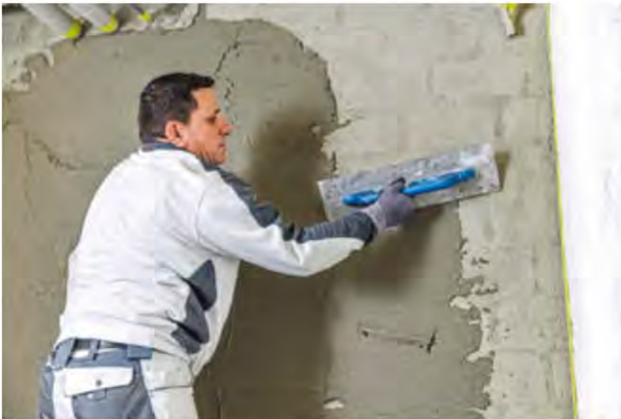
Die Kelleraußenwände wurden innen für eine tragfähige Oberfläche vorbereitet und mit Haftbrücke sowie Dichtputz versehen.
